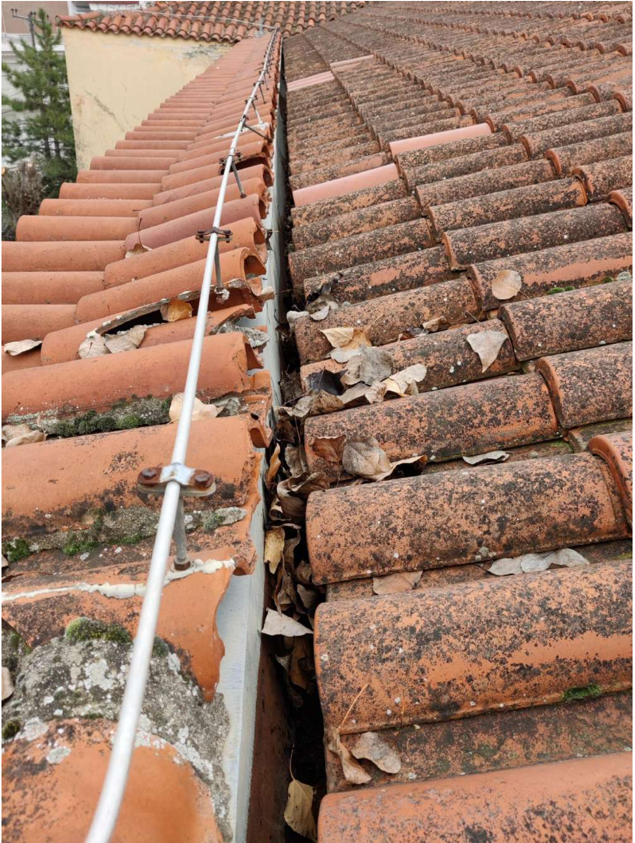
Εικόνα 3: Ενδεικτική κατάσταση σπασμένων κεραμιδιών και απόστασής τους από στηθαίο
